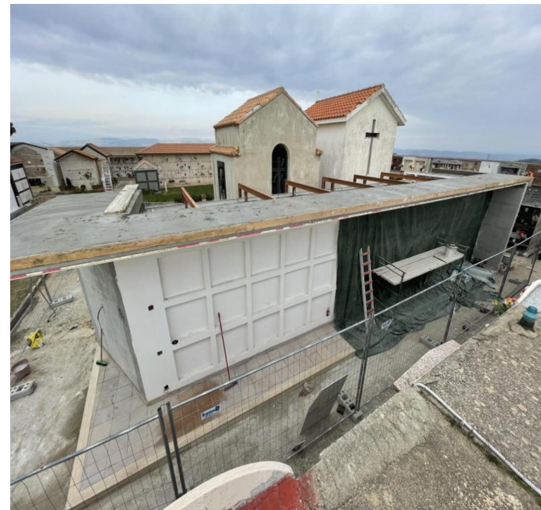
Strutture e copertura in corso di realizzazione: foto di archivio, non dettaglio di armatura.
